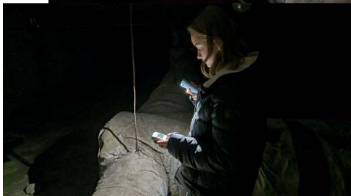
Рисунок 11. Измерение мощности в подвале.
